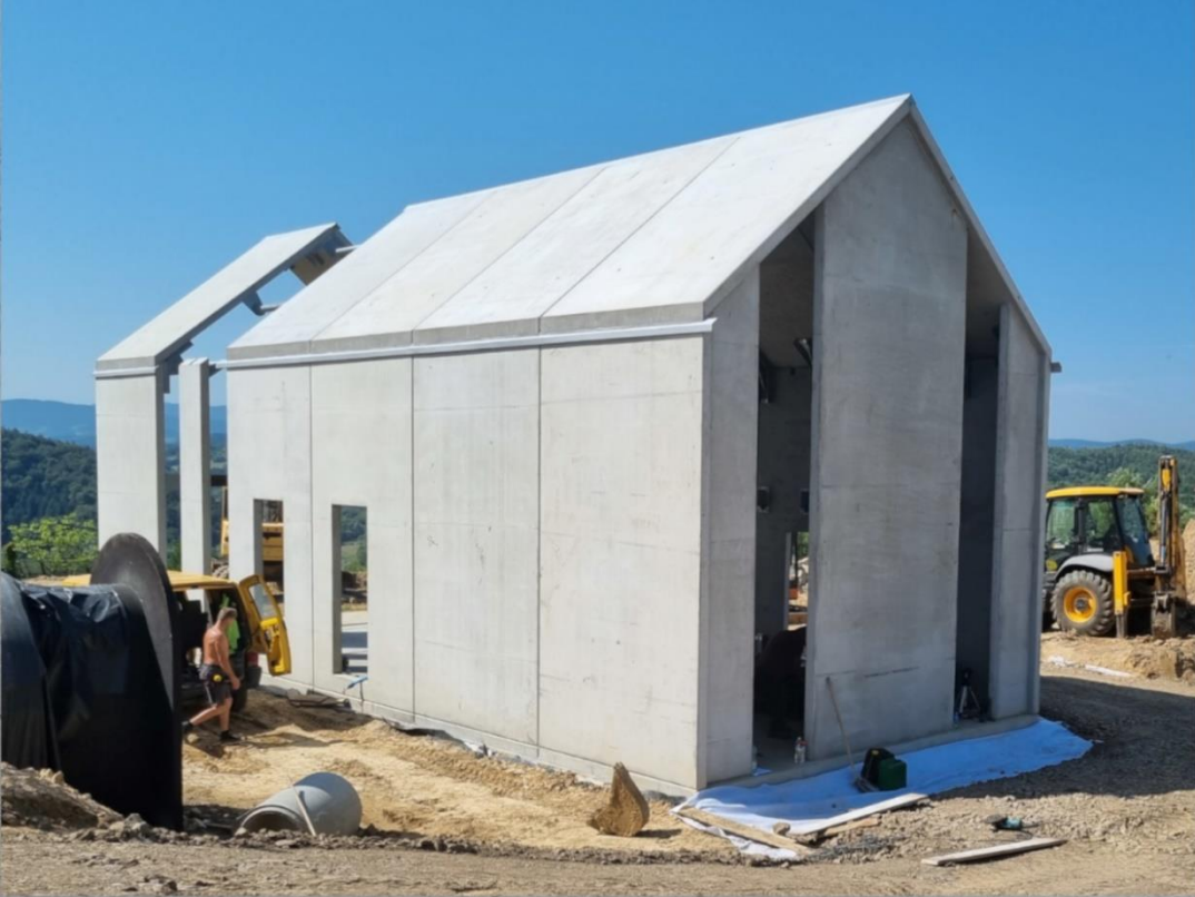
WYKONANIE OBRÓBEK BLACHARSKICH
